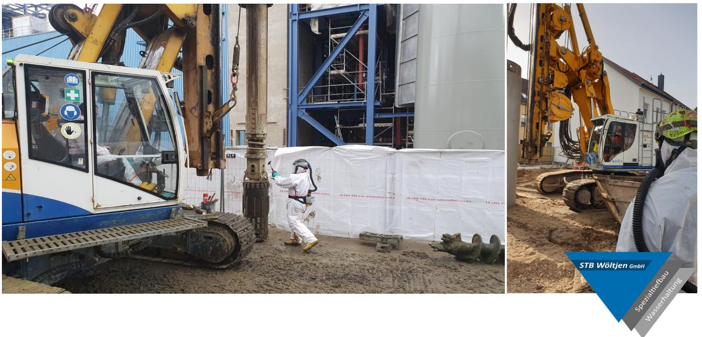
Bei der Bebauung von ehemaligen Industrie- oder Gewerbeflächen ergeben sich aus der historischen Analyse des Standortes oder durch die vorab geführten Baugrunduntersuchungen oft ein Hinweis auf Kontaminationen im Baugrund. Diese Bereiche sind anschließend planerisch gesondert zu untersuchen und führen zu weiteren notwendigen Leistungen. Im Bereich des Spezialtiefbaus gibt es mehrere Verfahren, die mit den Behörden und den zuständigen Stellen abgestimmt werden, u.a. können das folgende sein:
